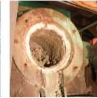
Fertig zum Ausdrücken mit der Ausdrückvorrichtung
