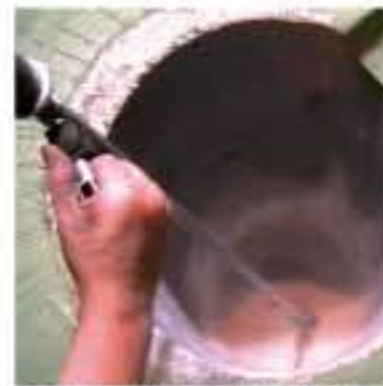
Die Montageöffnung wird mit Bodenschmelze gefüllt und verdichtet.
