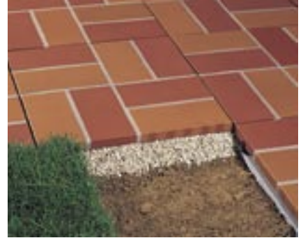
Kombinierte Verlegung auf Kies und Plattenlager.
