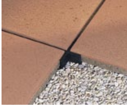
Kiesbettverlegung mit Fugenkreuz.
